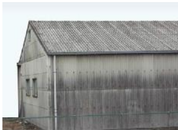
石綿含有スレート波板（屋根・外壁）
