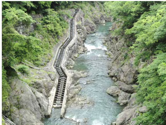
写真 左)白丸ダム 右)白丸魚道 白丸ダムの 30m の高低差を解消
