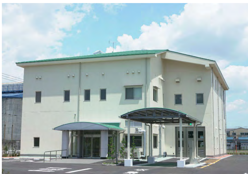
写真 西秋川衛生組合汚泥再生処理センター（玉美園）
