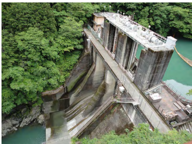
写真 左)白丸ダム 右)白丸魚道 白丸ダムの 30m の高低差を解消
