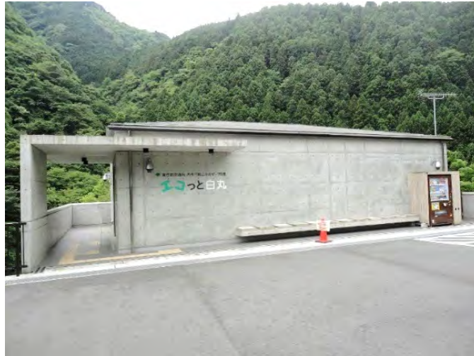
写真 再生可能エネルギーPR 館(エコっと白丸)
