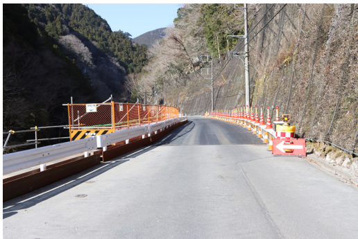
▶復旧した日原街道
