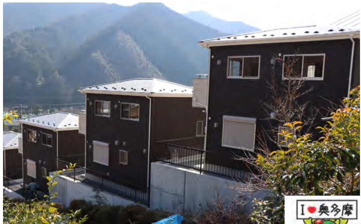
▲町営若者住宅（小丹波第4（宮ノ下）） （木造2階建て・2LDK 8戸）
