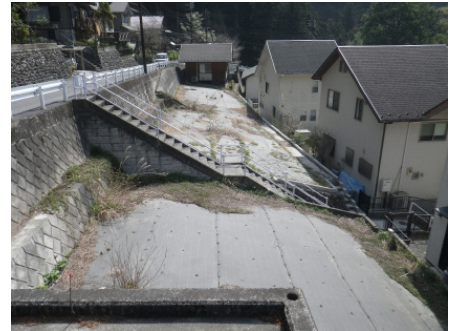
▲川井地区の分譲地
