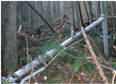
▶倒壊した電柱（海沢地内）
