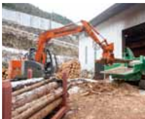
②破砕機に木材を投入
