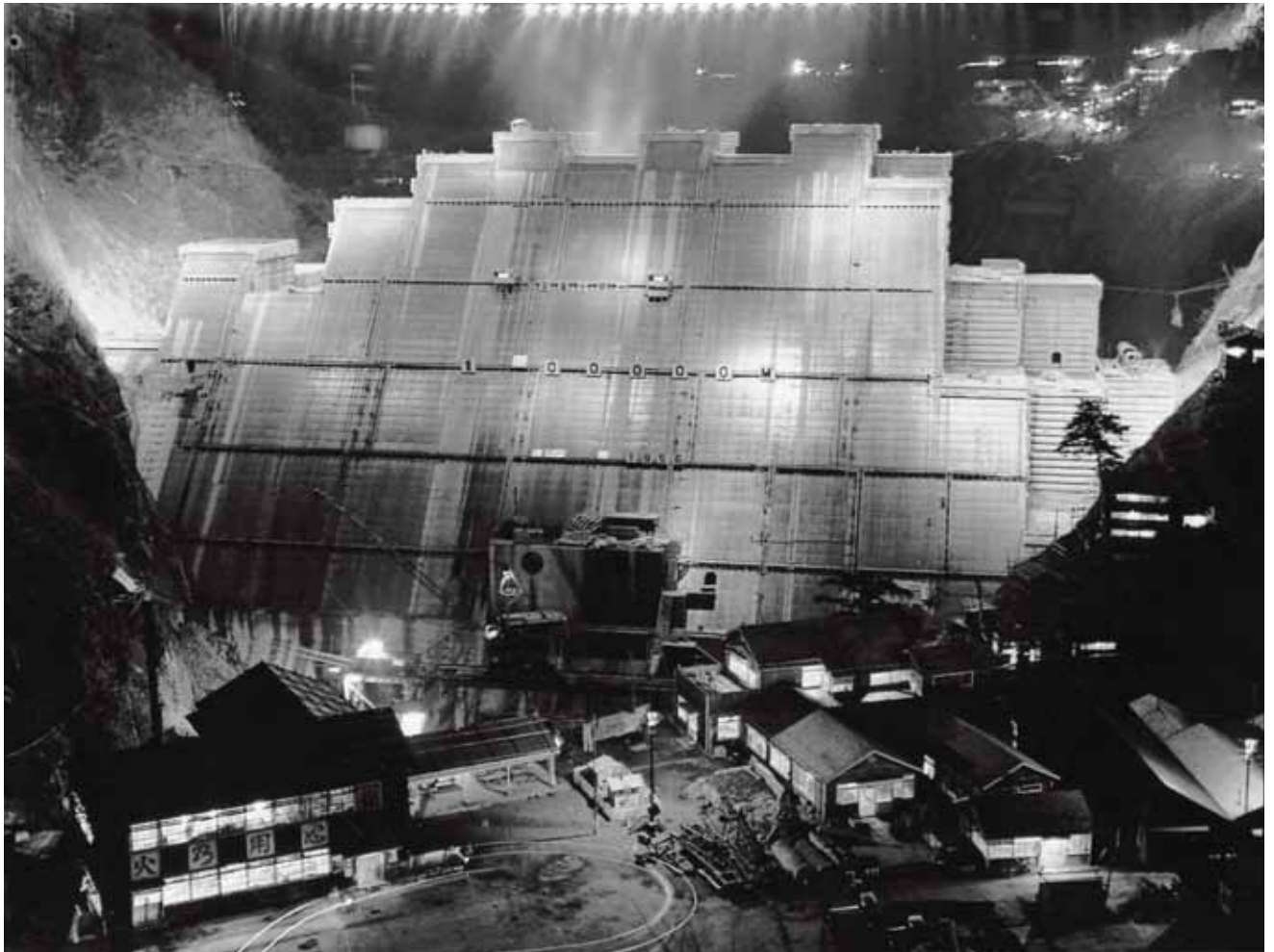
ダム建設の夜景 小河内ダム(奥多摩湖)は昭和13年11月着工、昭和18年10月戦争で中止、昭和23年9月再開、昭和32年11月完成 昼夜を問わず建設中のダムの夜景 【撮影】昭和20年頃
