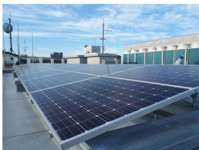
太陽光パネルの設置 参考（東京都瑞穂町）
