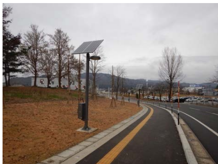
街路灯の設置 参考（新潟県魚沼市）
