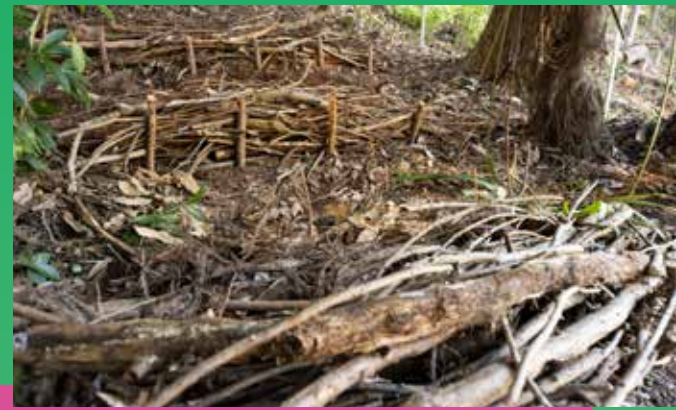
地形を見て地中の水の流れを読み取りながら、森に道を作っていく Photo/Shinnosuke Suzuki
