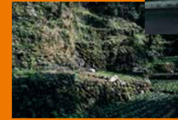
崩れた石垣を修復し、水の流れを整えていく
