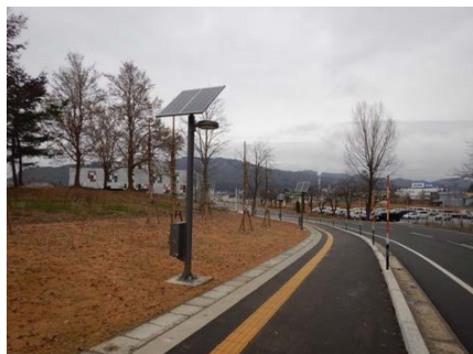
街路灯の設置 参考（新潟県魚沼市）
