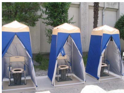
マンホールトイレ 参考（京都府長岡京市）
