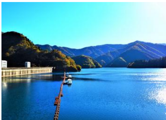
竣工70年を迎える小河内ダム
