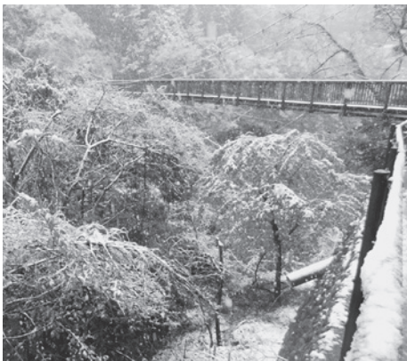
〈もえぎ橋付近〉
