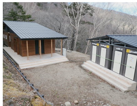
▲五十人平野営場の管理棟とトイレ
